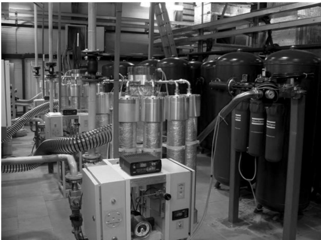
*Рисунок 2. Азотная мембранная установка*
