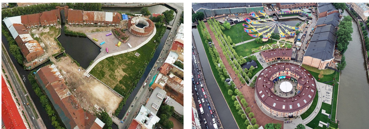
Рисунок 5. Реконструкция верфи на острове Новая Голландия, Санкт-Петербург [4], [5]
