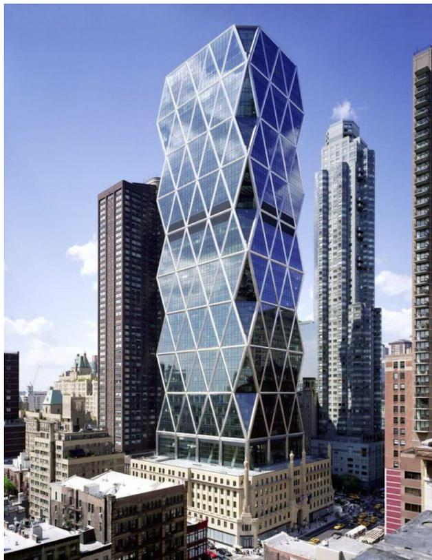
выполнены в виде диагридной системы, что представляет собой каркас из пересекающихся балок, создающих геометрические формы. В данном здании - треугольные фермы, соединяющие между собой 4 грани башни. Удивительным в архитектуре данной постройки является то, что стеклянное сооружение вырастает из недостроенного здания 1928 года, а диагонально поставленные несущие колонны-ребра как будто опираются на старое строение. Само здание передает лиричность и грацию.
